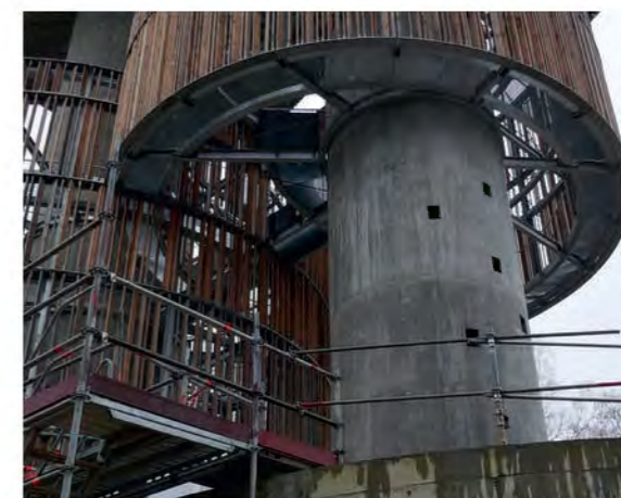
Cavités aménagées dans le pied du château d'eau pour y encastrer des abris destinés au murin de Bechstein © BIOMONITOR
