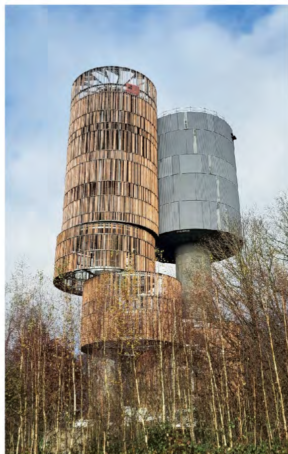
Foto aus der letzten Bauphase vom Boulevard Pierre Frieden © Temperaturas Extremas Arquitectos
