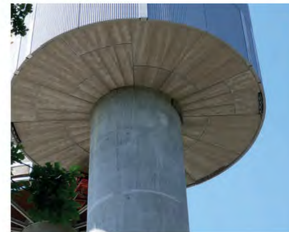
Abris pour chauves-souris (en groupes) placés sous l'un des réservoirs du château d'eau © BIOMONITOR
