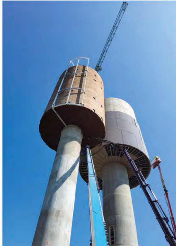
Pose des façades différentes (éléments béton préfa et sous construction) © LSC-Group
