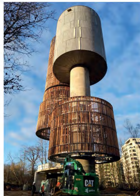
Le projet lauréat du château d'eau, temperaturas extremas architectes et Simon-Christiansen Ingénieurs © BALLINIPITT
