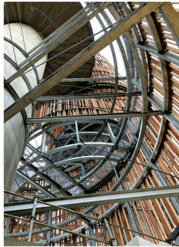
Charpente métallique finale. Pose des escaliers (en forme de demi-lune) © LSC-Group
