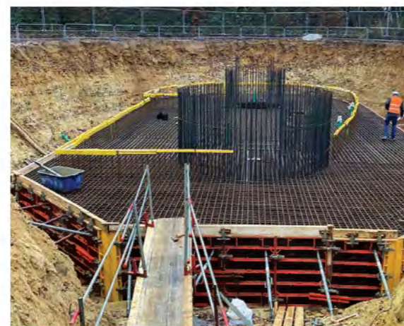
Ferrailage fondation © LSC-Group
