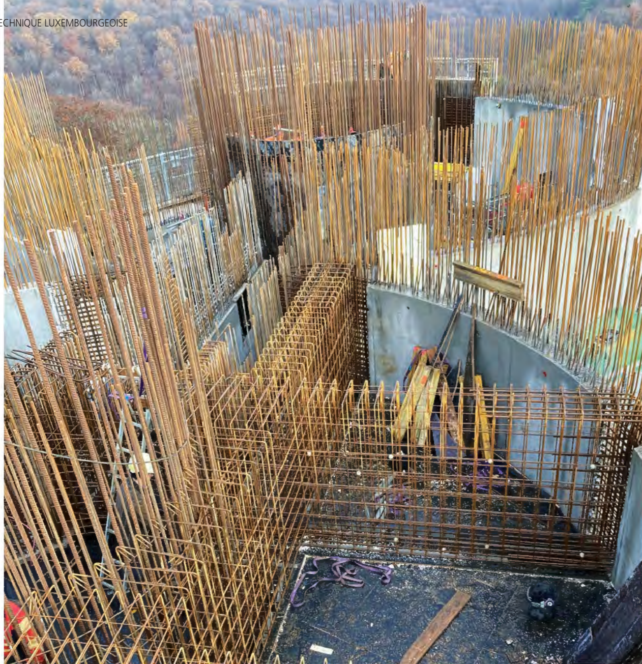
Ferrailage des poutres principales supérieures © LSC-Group
