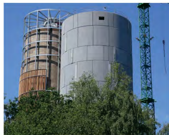
Château d'eau en phase de construction avec emplacement du nichoir pour faucon pèlerin en haut de la tour © BIOMONITOR
