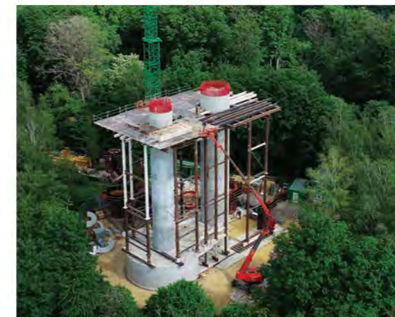
Mise en œuvre plateforme de construction © LSC-Group
