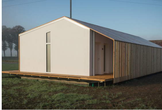
_Abb. 9: Fertigstellung Tennis Club Lorentzweiler
