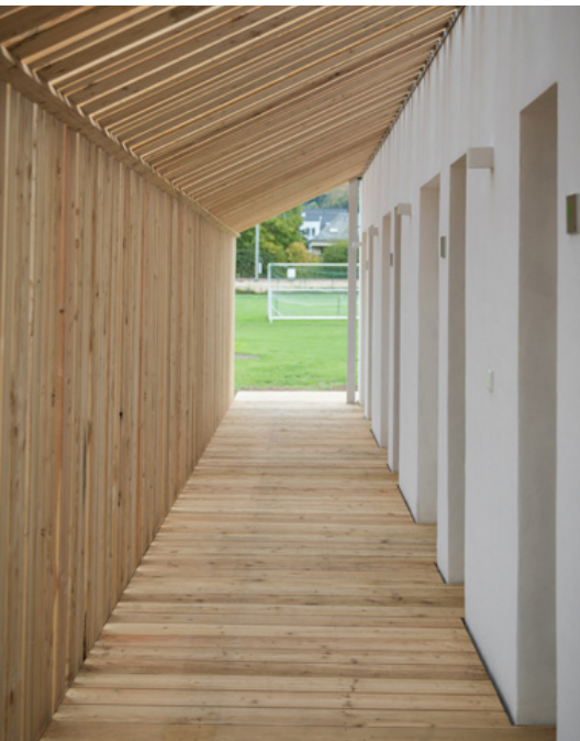
_Abb. 10: Fertigstellung Tennis Club Lorentzweiler
