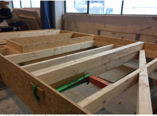
_Abb. 6,7: Schalung für die Miscanthus-Wandelemente
