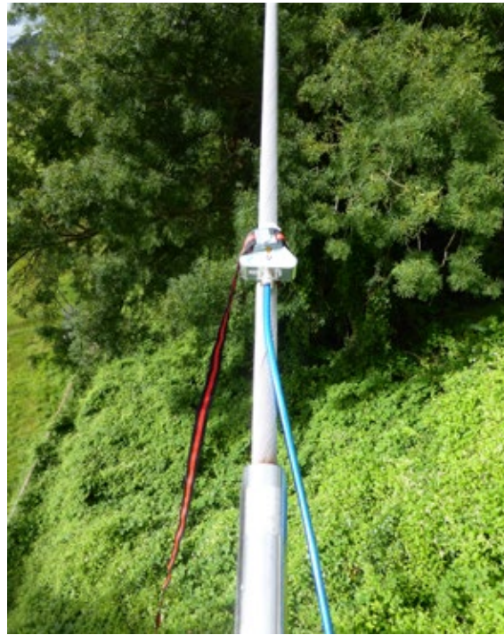
Abb. 1: Befestigung der Sensorbox: links an einem Abspannseil und rechts an einem Hänger der Stadthafenbrücke Sassnitz
