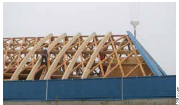
_Montage der in de Dämmebene liegenden Dreigelenk-Bogenbinder
