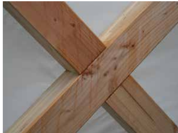
_Kreuzungspunkt der tragenden Fassadenriegel
