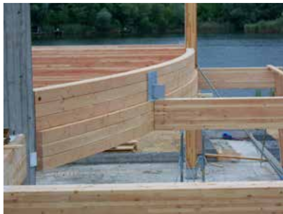
_Gekrümmter Torsions-Biegeträger
