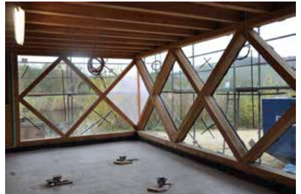
_Bild 7: Biodiversum Bauzustand Rautenfachwerk 2013
