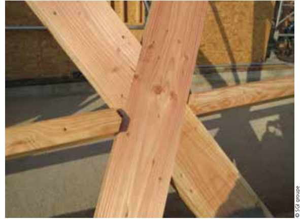
_Kreuzungspunkt der zweiten Lamellenlage auf dem Lehrgerüst
