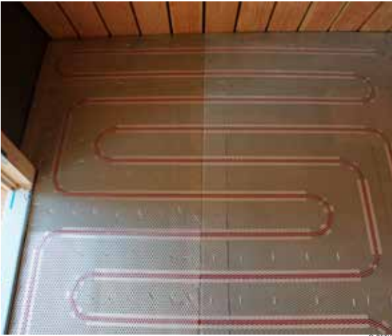
_Fussbodenheizung Detail
