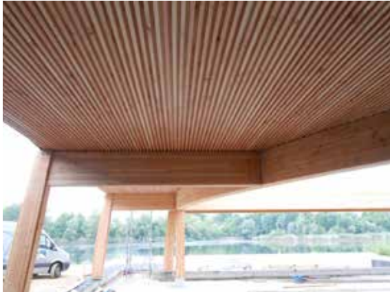
_Deckenuntersicht der Brettstapeldecke mit unterschiedlich breiten Brettern
