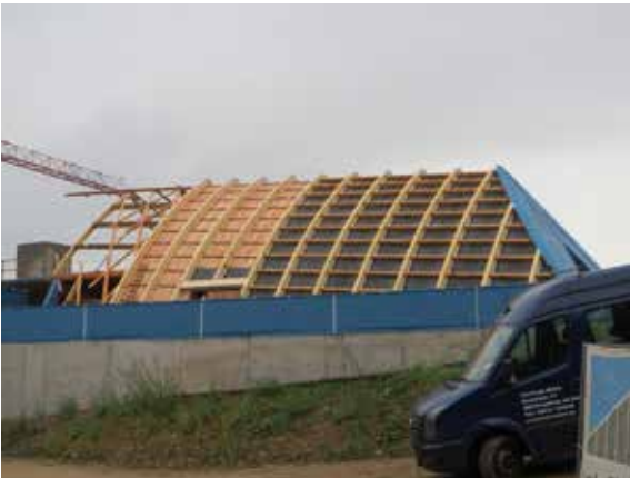
_Zwischen den Bogenbindern eingebaute Bretterschalung
