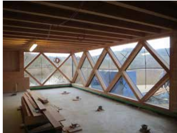
_Zum Lastabtrag herangezogene Fassadenstruktur
