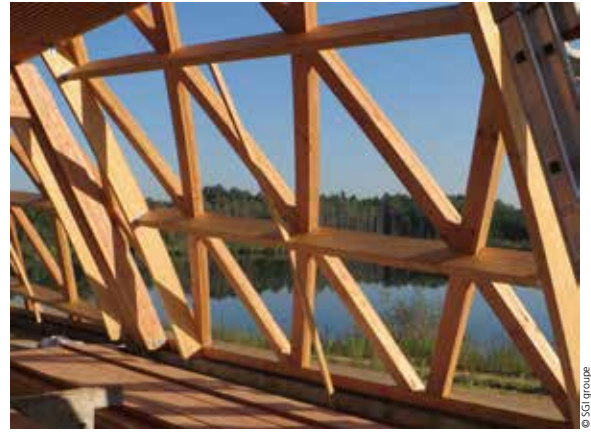
_Innenansicht der auf dem Lehrgerüst fertig montierten Brettrippenschale
