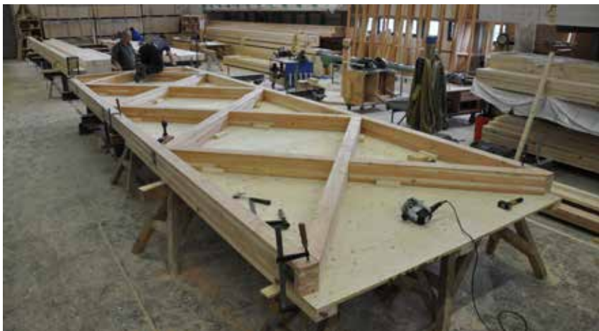
_Bild 1: Montage eines Elementes im Werk
