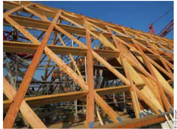
_Montage der Brettrippenschale auf dem Lehrgerüst
