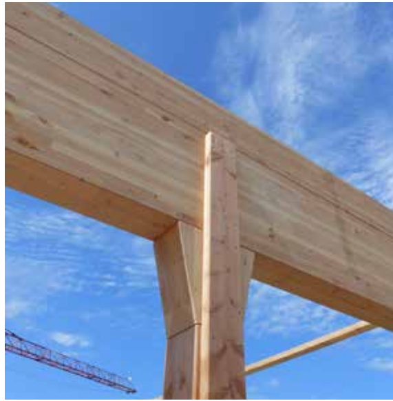
_Balkenaullager mittels Kapitell und seitlicher Kippsicherung
