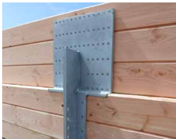
_Stahlformteil zur Torsionseinspannung des aufgelegten Trägers
