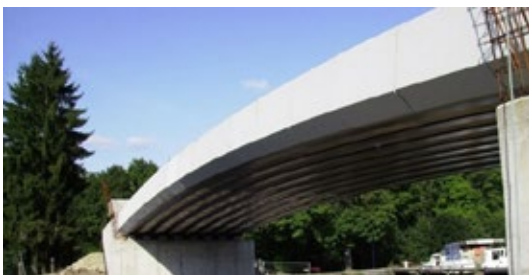
_Abb.1: Eisenbahnüberfahrt in Niderviller (Frankreich) [TRA11] [W2]
