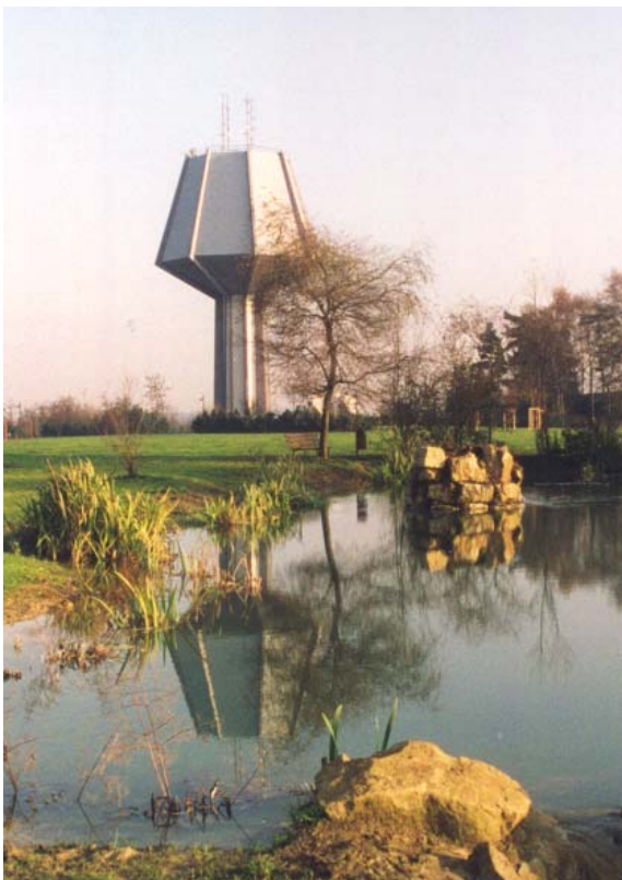
Le château d'eau de 2000 m 3 au Kaltreis à Bonnevoie fut construit entre 1981 et 1988 et couta 82.343.979.- francs luxembourgeois. (+/- 2.041.254 Eur)
