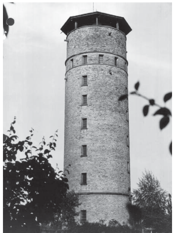
Le château d'eau Route d'Arlon au lieu dit "Windmuhl"
