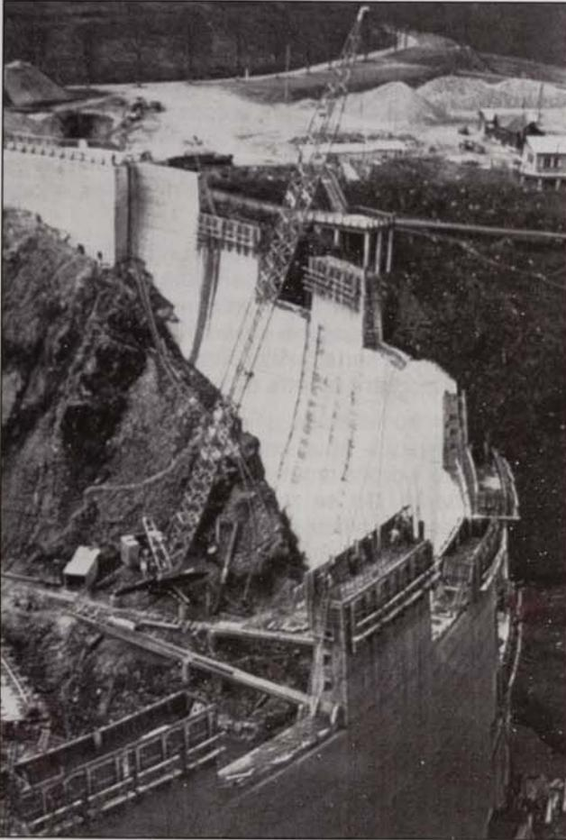
Photo 1: Bétonnage de la voûte.
