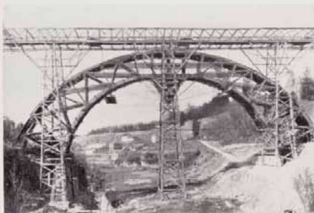
Fig. 30 — Le pont de service et le cintre monté.
