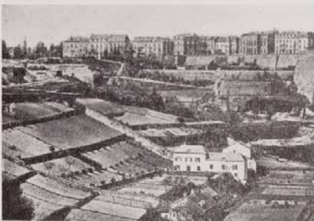
Fig. 3 — Vue prise du côté de l'ancien viaduc avant la construction du pont.
