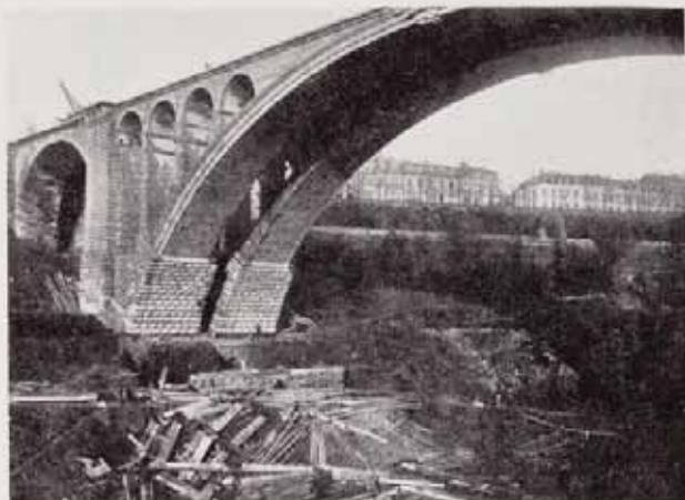
Fig. 42 — Le pont décintré.
