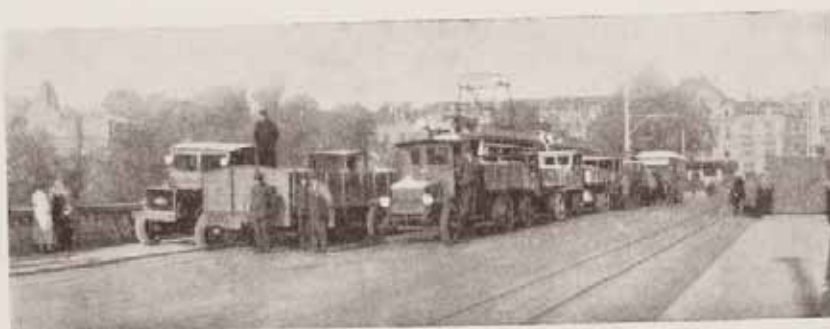
Fig. 7 — Charge roulante, composition «A», poids total 225,75 t, longueur 41,42 m.
