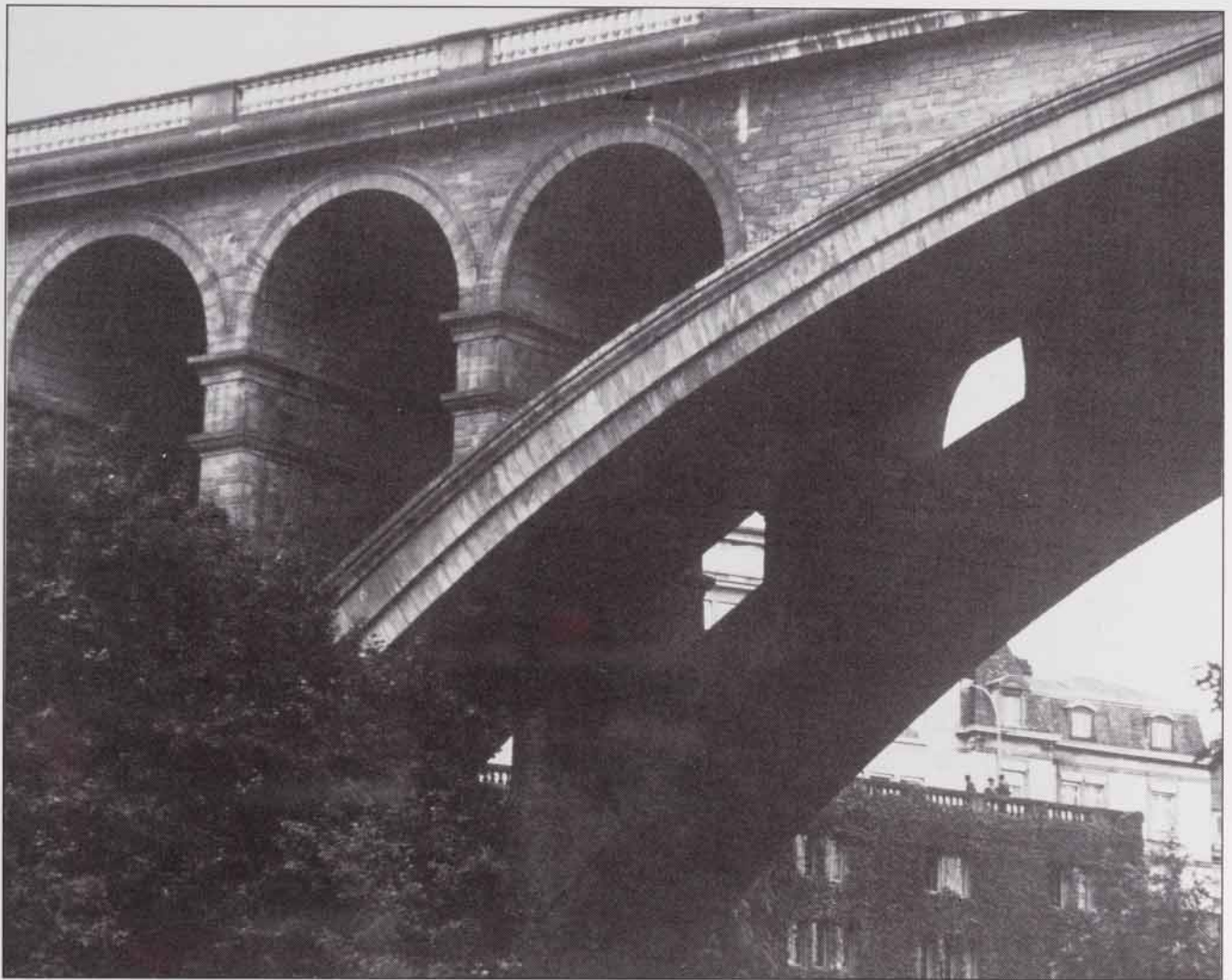
Fig. 10: Le pont Adolphe (détail).
