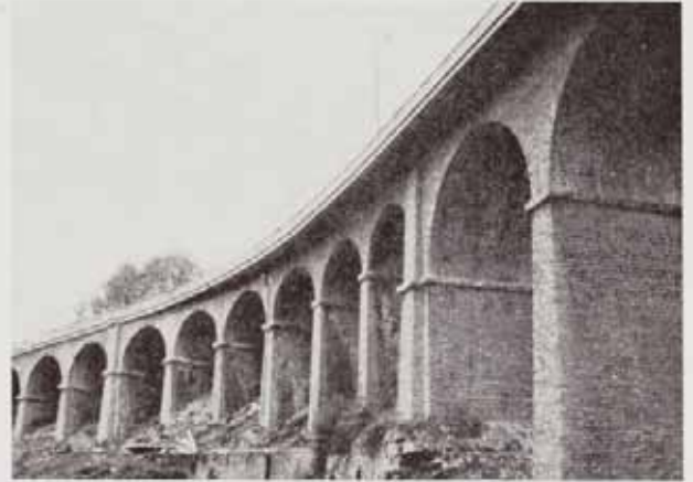
Fig. 11. — Vue partielle de l'ouvrage élargi.
