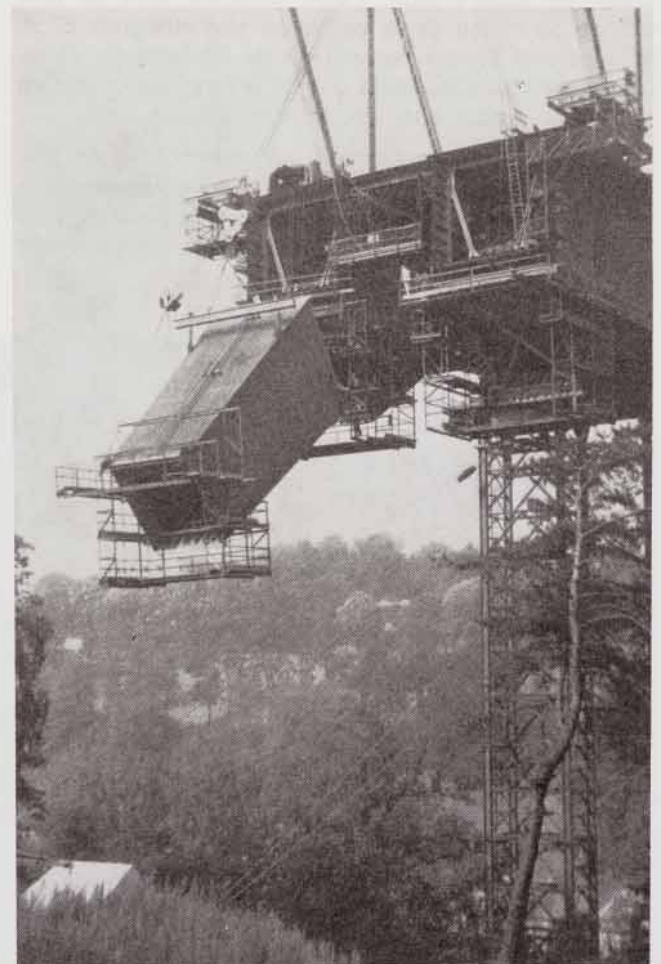
Fig. 10. Montage d'un caisson de béquille côté Kirchberg
