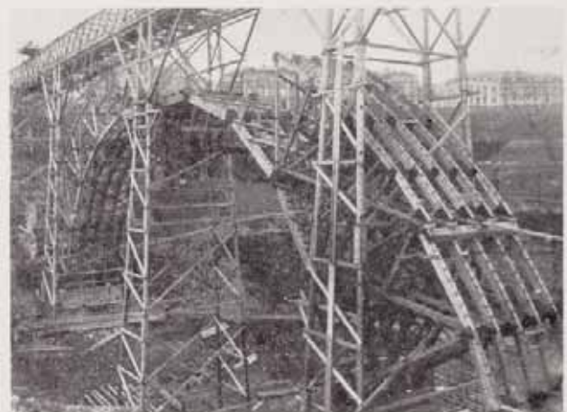
— Fig. 28 — Montage du cintre.
