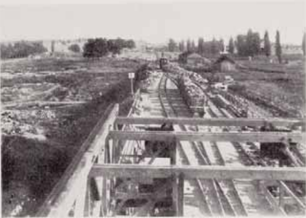
Fig. 25 — Chantier d'approvisionnement du plateau Bourbon.
