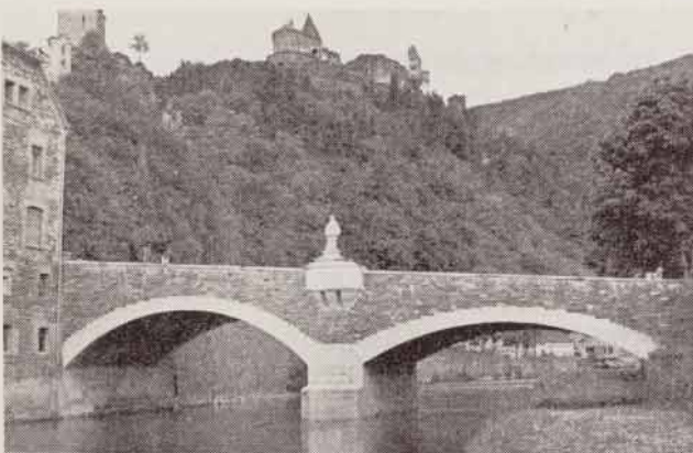
Fig. 4. — Pont sur l'Our à Vianden.
