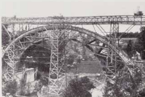
— Fig. 32 — La première voûte est terminée.
