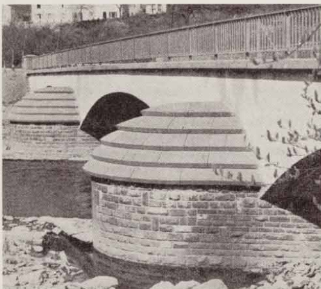
Fig. 8. — Pont sur l'Our entre Bettel et Vianden. Détail.
