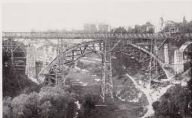
Fig. 33 — Travaux de maçonnerie aux pilastres et aux voûtes d'évidement.
