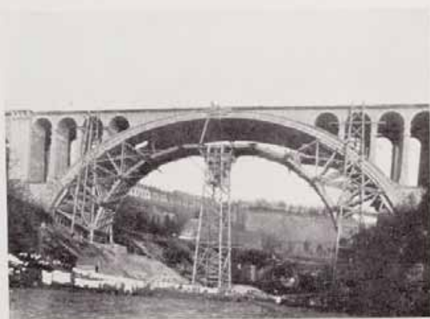
Fig. 41 — Démontage du cintre.
