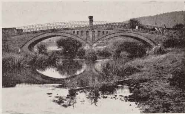
Ancien pont en maçonnerie. (Photo Kutter.)
