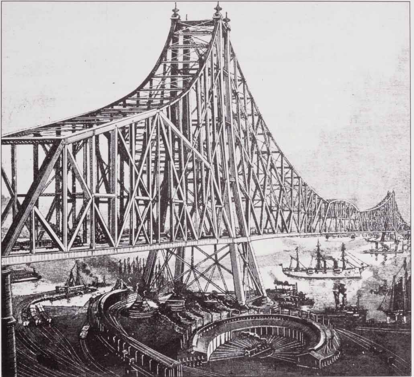
Fig. 7: Pont sur l'Hudson (1890). Portée 700 m.
