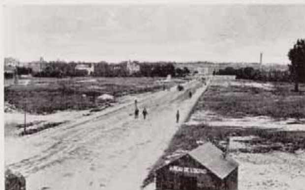
Fig. 43 — L'avenue de la Liberté conduisant au pont terminé.
