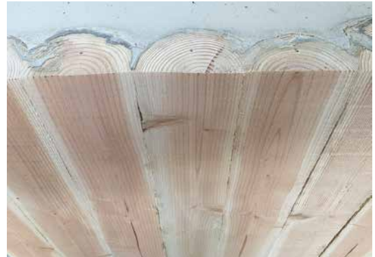
_Bild 9 - Hybridelement, Grenzzone Holz – Beton
