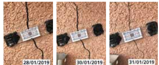
_Redressement du bâtiment - fermeture des fissures
