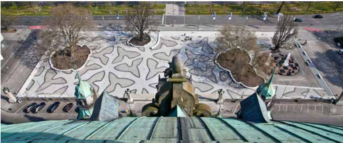
_La Tramme Place avant l'Aménagement
