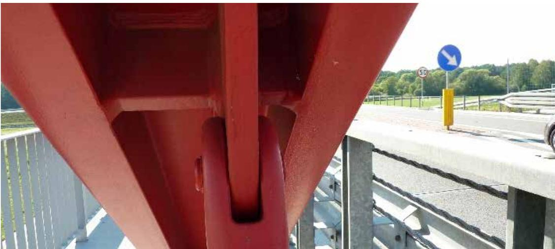
Bild 8: Hängeranschluss am Bogen bei Brücke WD-57, Rawicz (Polen)
