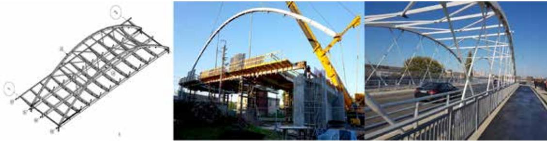
\_Bild 2: Überführungsbauwerk Wiadukta na Zatorze in Elblag (Polen) mit 51m Spannweite. Links, Modell; Mitte: Einheben des vollständig vorgefertigten Bogens; Rechts: Fertige Brücke
