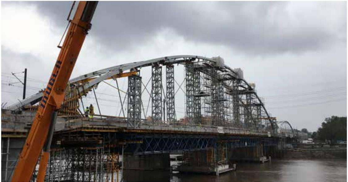
Bild 15: E-30 Eisenbahnbrücke in Krakau. Vorne: Bogen der großen, zentralen Spannweite im Bau; Hinten rechts: kleinere Bogenbrücke schon fertiggestellt
