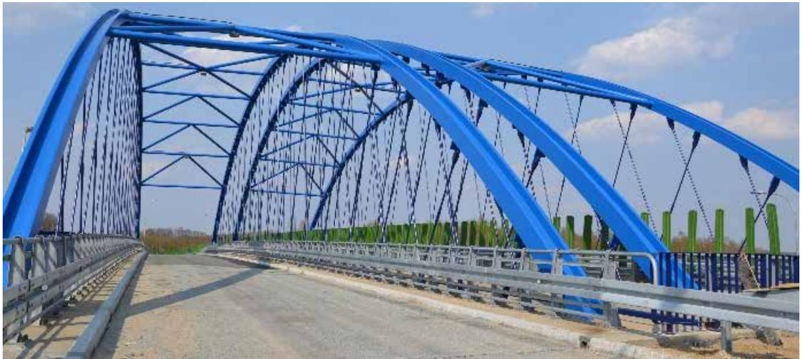
—Bild 6: Überführungsbauwerk WD-137 über Autobahn A4 (Tarnów Rzeszów) mit einer Spannweite von 72 m (Kaczmarek, et al., 2018)
