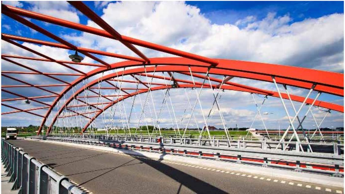
—Bild 5: Überführungsbauwerk WD-431 über Autobahn A1 (Pyrzowice – Piekary) mit einer Spannweite von 62m (Kaczmarek, et al., 2018)
