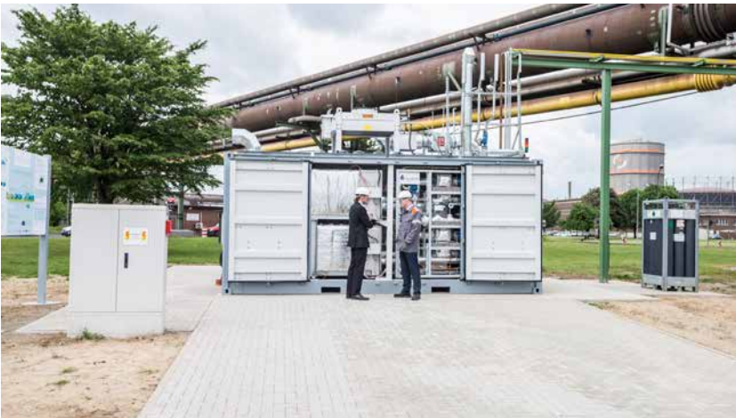
_Sunfire Dampf-Elektrolyse-Modul bei Salzgitter
