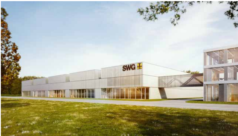
Die neue Halle der SWG Produktion hat beachtliche Abmessungen von 114m Breite auf fast 97m Länge. Markant ist die Dachkonstruktion mit den Versprüngen zwischen den fünf Hallenschiffen. Eine Brücke verbindet die Produktionshalle mit dem dreigeschossigen Besucher-Pavillon. Der Entwurf stammt von Architekt Hermann Kaufmann.
