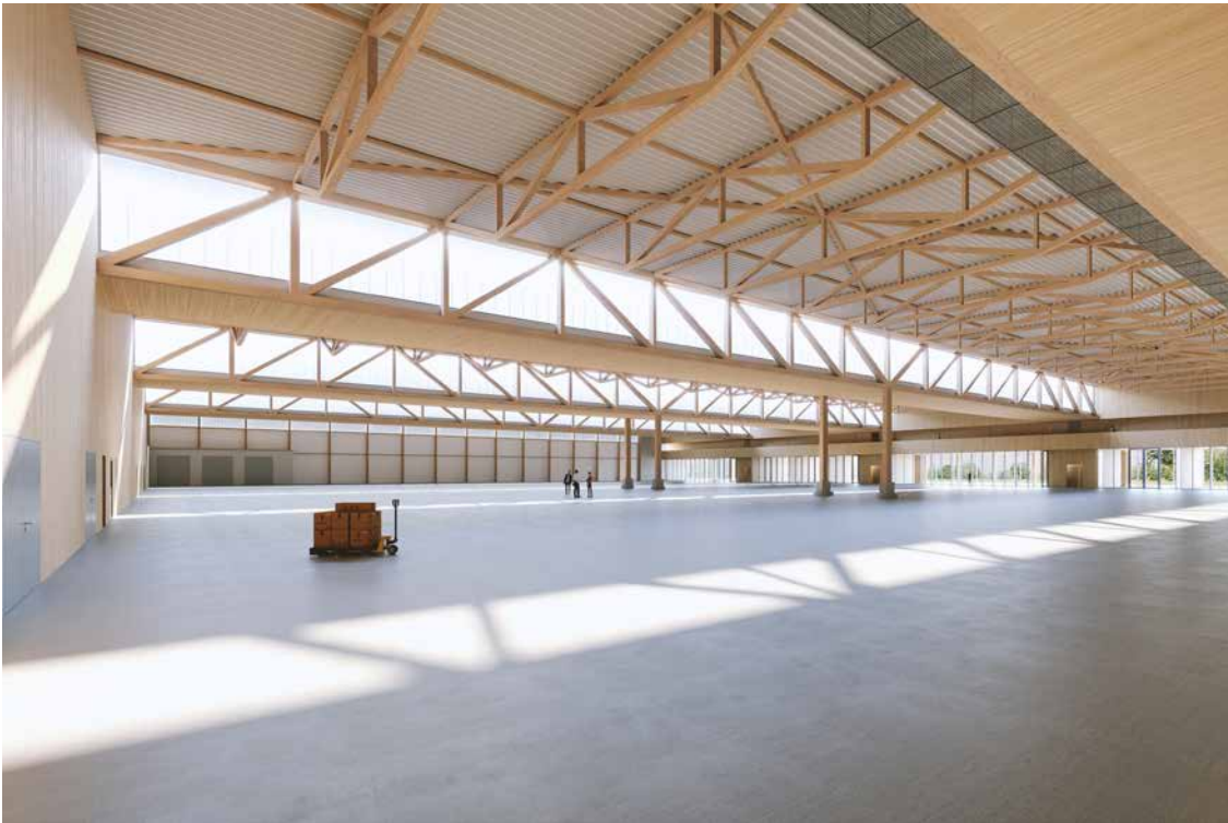
„Rund 82m lange Fachwerkträger mit nur einer Stütze überspannen als Zweifeldträger die Halle. BauBuche ermöglicht es, die Feldweiten von 40m bzw. 42m mit filigränen Träger-Abmessungen zu überbrücken. (Visualisierung: HK Architekten)“
