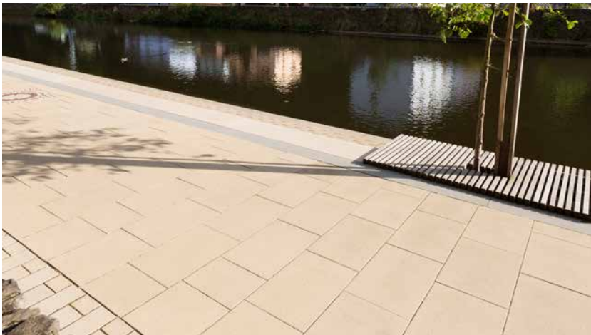
_Vianden, Esplanade d'Our: CONTERN-Platten aus Beton im Format 750 x 500mm bieten ebene Oberflächen mit geringem Fugenanteil © Contern S.A.
