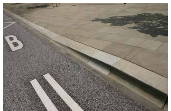
_Luxemburg-Stadt, Limpertsberg: Kassler Querungsbord und Bordstein für Bushaltestellen kombiniert mit Contern-Platten aus Beton 750 x 500mm © Contern S.A.
