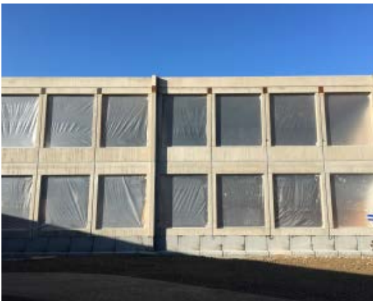
_Abb 15: Baustellenfoto erhaltene Betonstruktur
