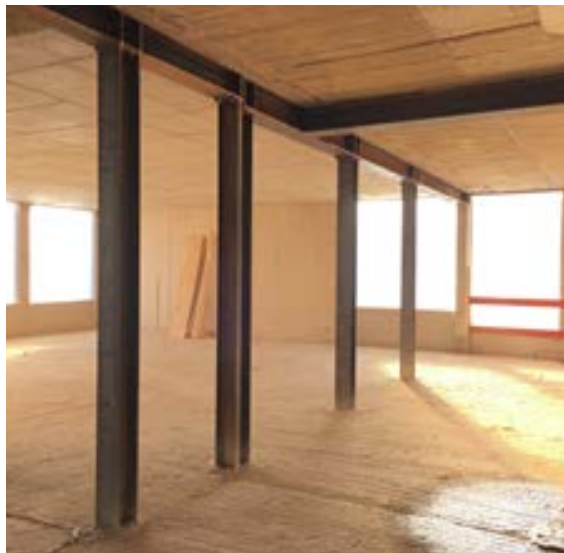
_Abb 16: punktuelle Strukturverstärkung der erhaltenen Betonelemente
