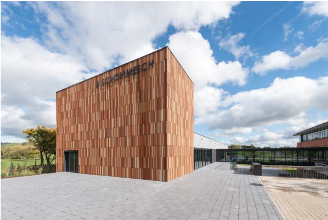
© Paul Scharlé / Architectes Perry Weber et Associés
