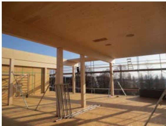
_Abb 17: gewährleistung der Umbaufähigkeit durch nichttragende Innenwände
