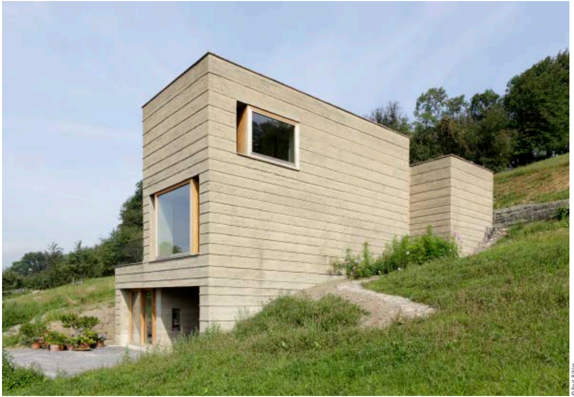
Abb 18: Süd-Ostansicht Haus Rauch
