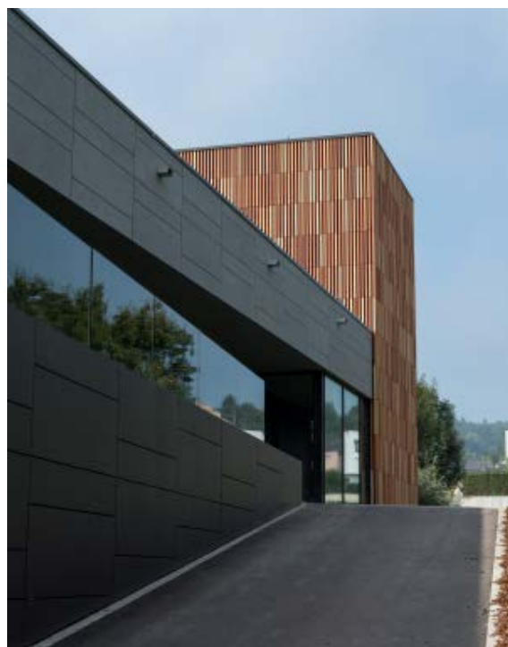
© Paul Scharlé / Architectes Perry Weber et Associés
