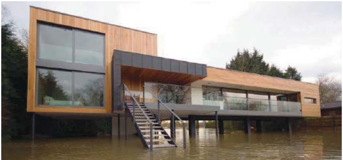
Anhebung eines Gebäudes über das Hochwasser durch aufgeständerte Bauweise
