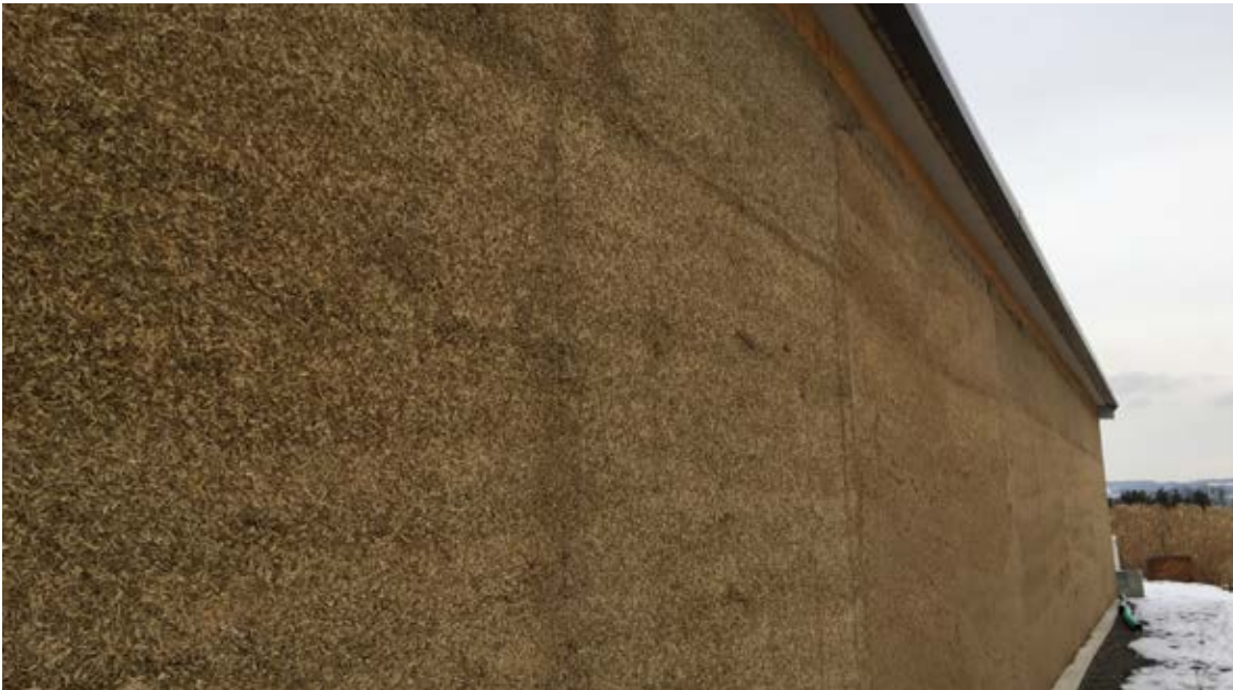
_Rückenwand der Lagerhalle von Miscanthus.lu aus Miscanthusbauerelementen auf dem Kranzenhaff
