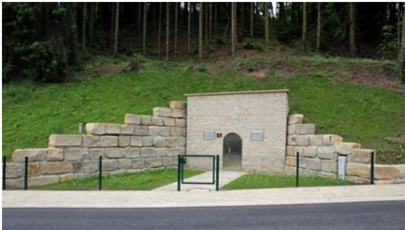
Sanierter Quelle Lichtebirchen in Simmern
