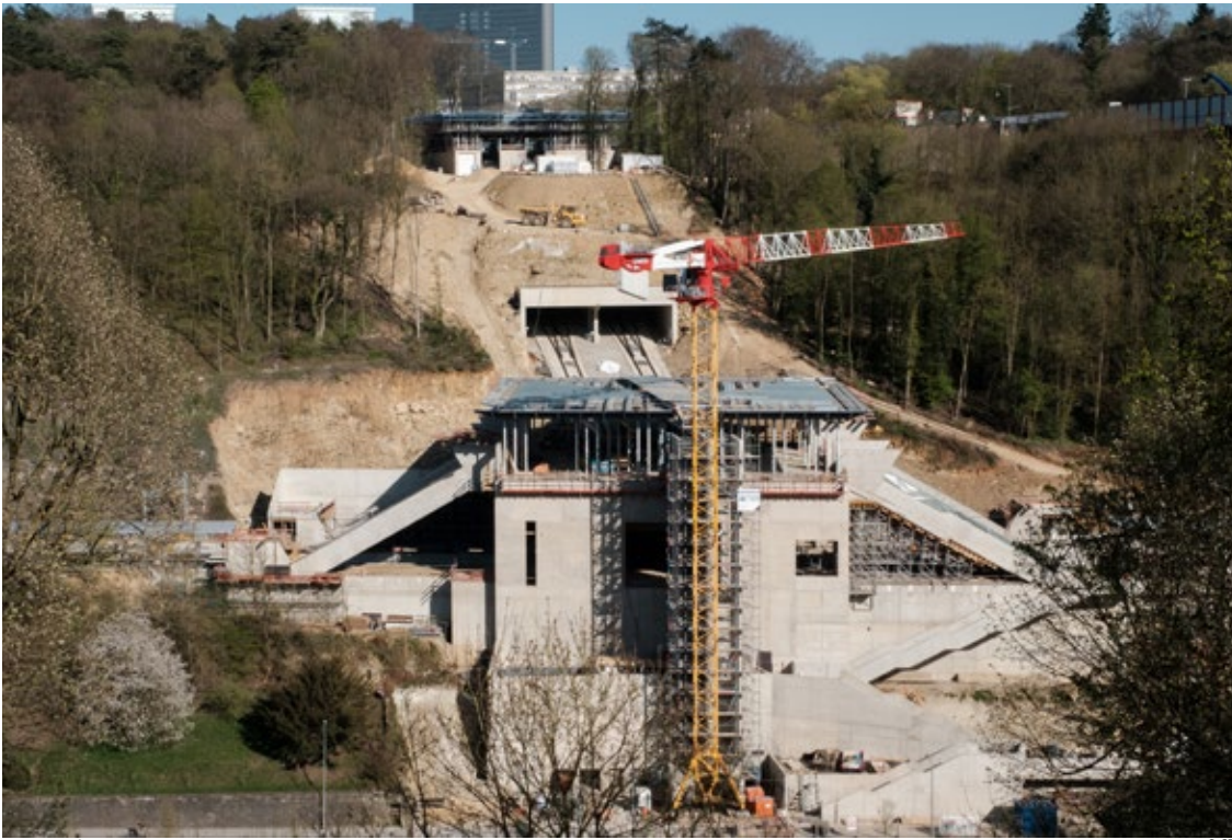
_Blick auf die Baustelle im April 2017
