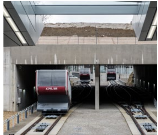
_Blick auf die 2 Standseilbahnen mit Tunnelbauwerk
