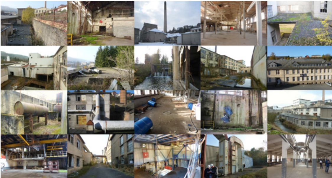
_Abb. 11: Die Industriebrachen vor dem Abbruch
