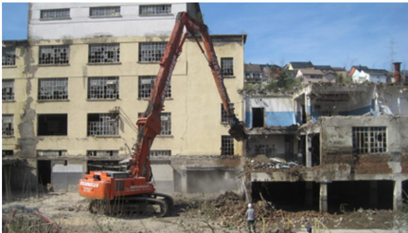
_Abb. 1: Abbruch der Tragstruktur von Gebäude 16 (10.04.2014)
