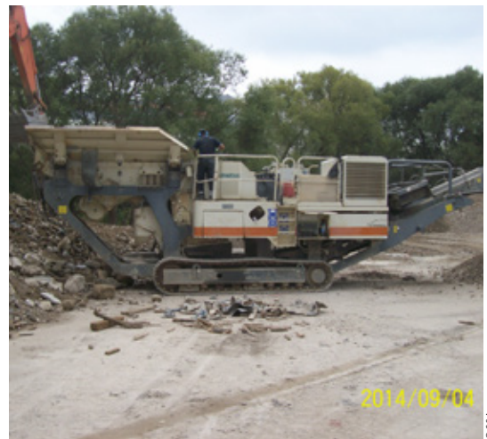
_Abb. 6: Brecher zum Zerkleinern des Abbruchmaterials (04.09.2014)
