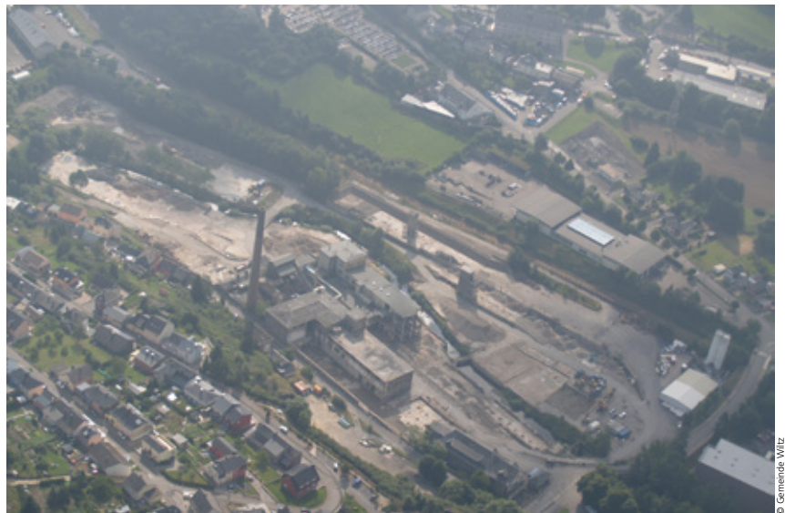
_Abb. 5: Das Gelände während des Abrisses. Die Haufwerke sind auch von Oben zu erkennen. (30.07.2014)
