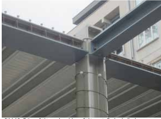
Bild 12. Träger-Stützen-Anschluss, Stützenstoß oberhalb der Deckenebene, Wendelbewehrung für spätere Betonummantelung der Stützen (CR)
