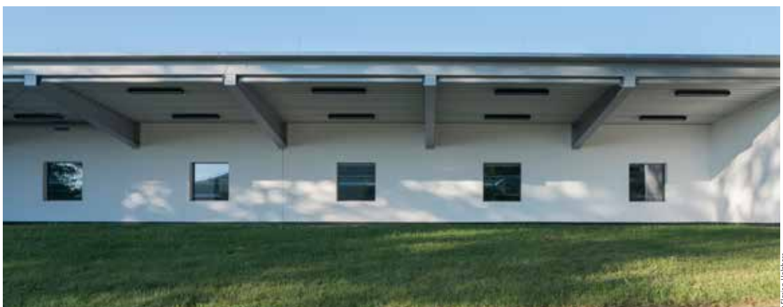
_Die topografisch bedingte, eingeschossige Nordseite gewährt Einblicke und bietet einen geschützten Freibereich für studentische Feste
