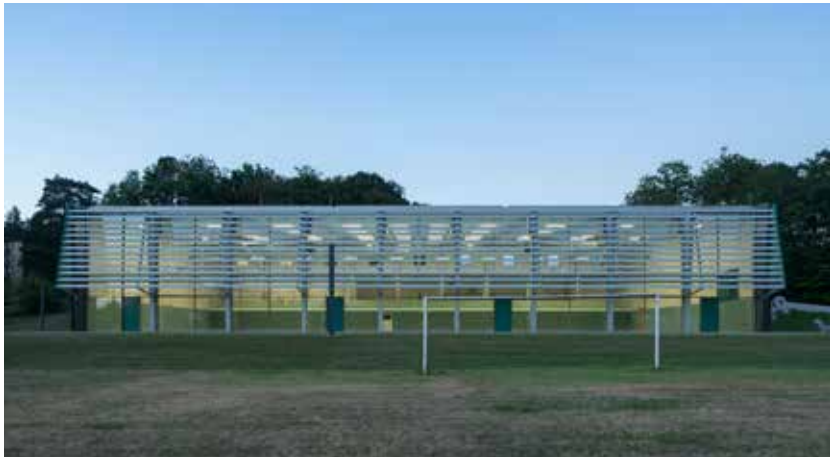
Die vollverglaste Südseite öffnet die Halle zur Landschaft. Der Sonnenschutz wird durch eine horizontale filigrane Lamellenstruktur gewährleistet
