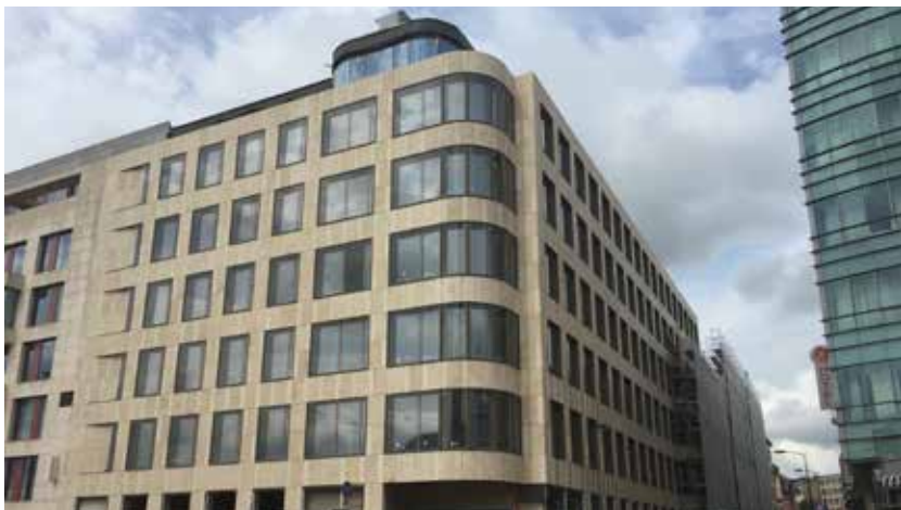
Bild 1. Ansicht Projekt KONS von der Place de la Gare mit in der Höhe beschränkter Fassadenfront, gestaltet mit Natursteinplatten (CR)
