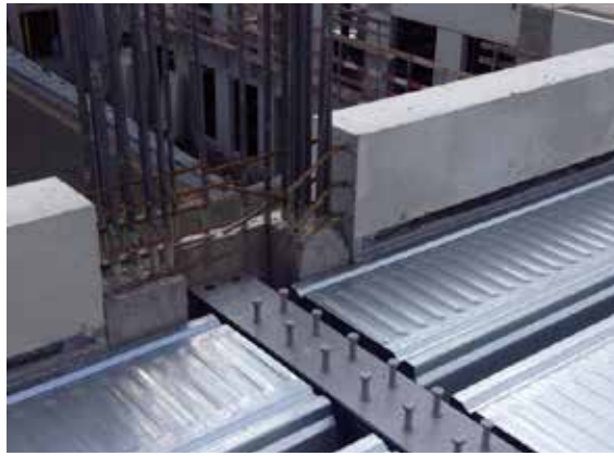
Bild 9. Auflagerung der Slim-Floor-Träger in Aussparungstaschen, Ausrichten erfolgt vor dem Betonieren; Brüstung in Form von Fertigteil-Elementen
