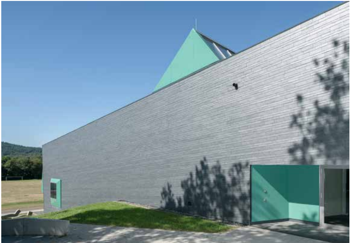
_Eingang von Osten. Schiefer als regionaltypischer Baustoff. Vor- und Rücksprünge - Auge, Dachreiter und Eingang - in Grün
