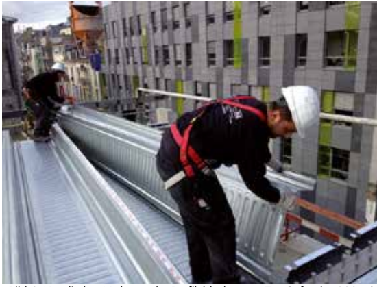
__Bild 6. Händisches Verlegen der Profibleche vom Typ Cofraplus 220 mit Schottblechen als Endauflagerung
