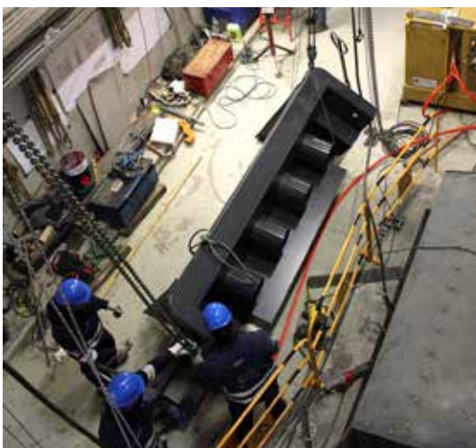
_Arbeiten im Untergeschoss
