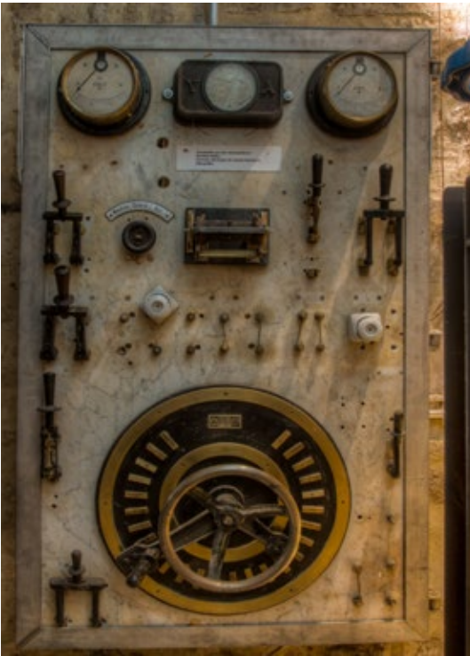
_Tableau en marbre pour endencher l'électricité de l'ancien moulin d'Oberpallen, aujourd'hui au Millemusée de Beckerich (photo de l'auteur) et ancienne photo d'Arthur Waxweiler, chargé de la fourniture d'électricité à Beckerich © dmillen.tu
