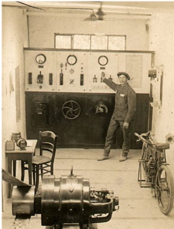
_Tableau en marbre pour endencher l'électricité de l'ancien moulin d'Oberpallen, aujourd'hui au Millemusée de Beckerich (photo de l'auteur) et ancienne photo d'Arthur Waxweiler, chargé de la fourniture d'électricité à Beckerich © dmillen.tu
