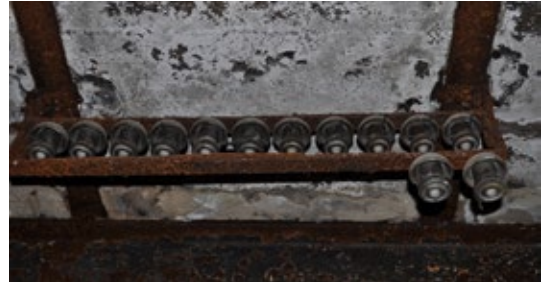
— Anciens isolateurs du moulin Waxweiler utilisés pour transporter l'électricité au village
