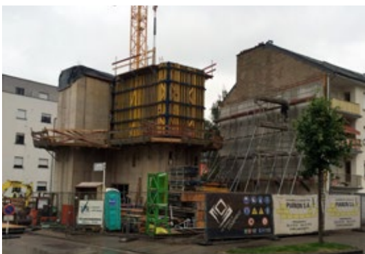
_gros œuvre terminé
