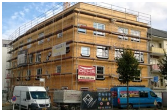
_charpente bois terminée
