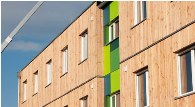
Die dreigeschossigen Riegel dokumentieren in puncto Baugeschwindigkeit, Materialität, Wohnkomfort und architektonischem Anspruch, welche weitreichenden Möglichkeiten in der systemischen Holzrahmenbauweise mit hohem Vorfertigungsgrad stecken.
