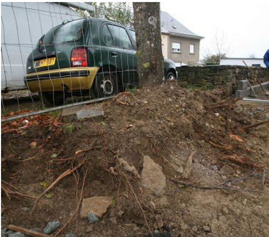
_3&4 Zerstörte Wurzeln durch unsachgemäßes Arbeiten im Wurzelsystem von Bäumen.
