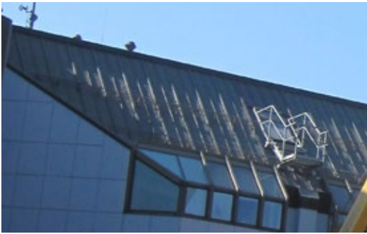
_2 Balcon pour nettoyage de verrière
