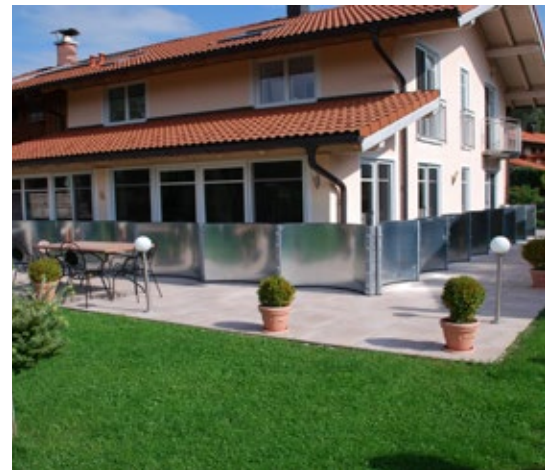
Jetzt kann das Hochwasser kommen: Aufgebautes Schutzsystem HWS-mobil vor dem Gebäude. Ist die Gefahr vorbei, verschwindet alles platzsparend in Keller oder Garage
