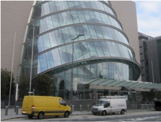
_4 Verrière à rendre accessible pour maintenance
