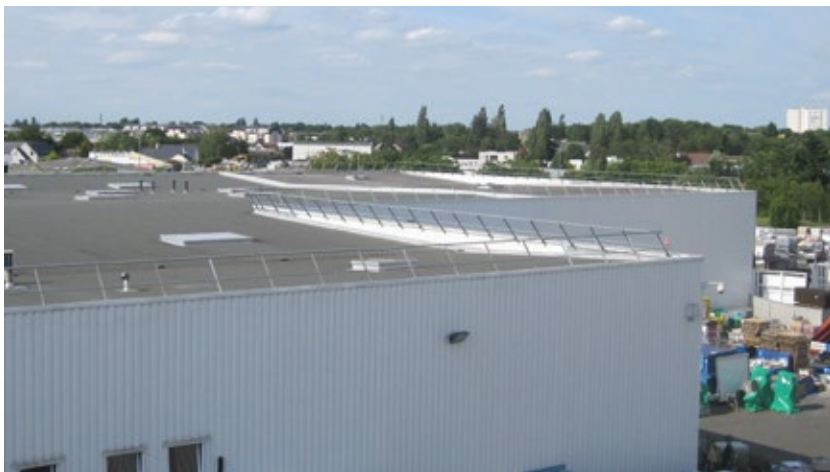
_1 Garde-corps en bord de toiture
