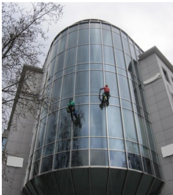
_6 Alpinistes nettoyant une façade vitrée
