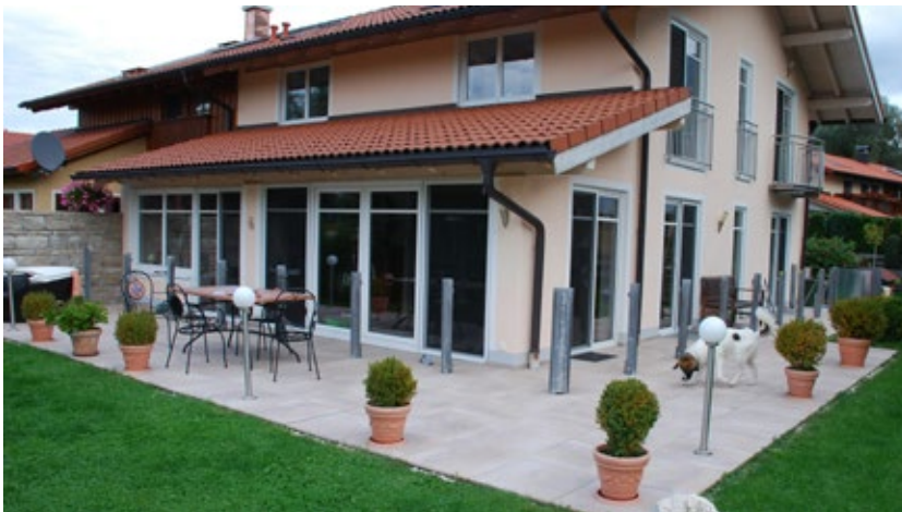
Die Stützen werden in den Bodenhülsen verankert
