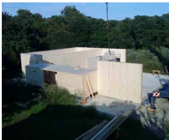
Montage der Holzbox aus massiven Thoma Holz100- Wand- und Decken-Elementen
