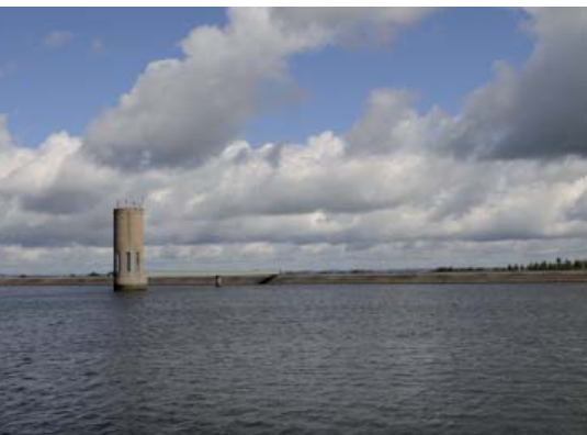
_Das Oberbecken mit dem Einlauf 1 für die Maschinen 1-4
