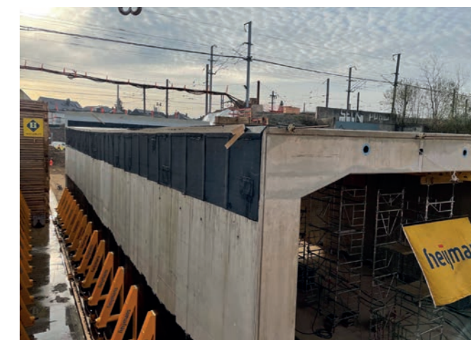
Premier cadre en cours de ripage
