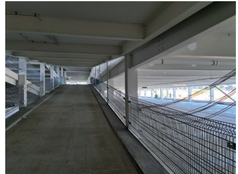
Rampe d'accès aux étages © Schroeder & Associés
