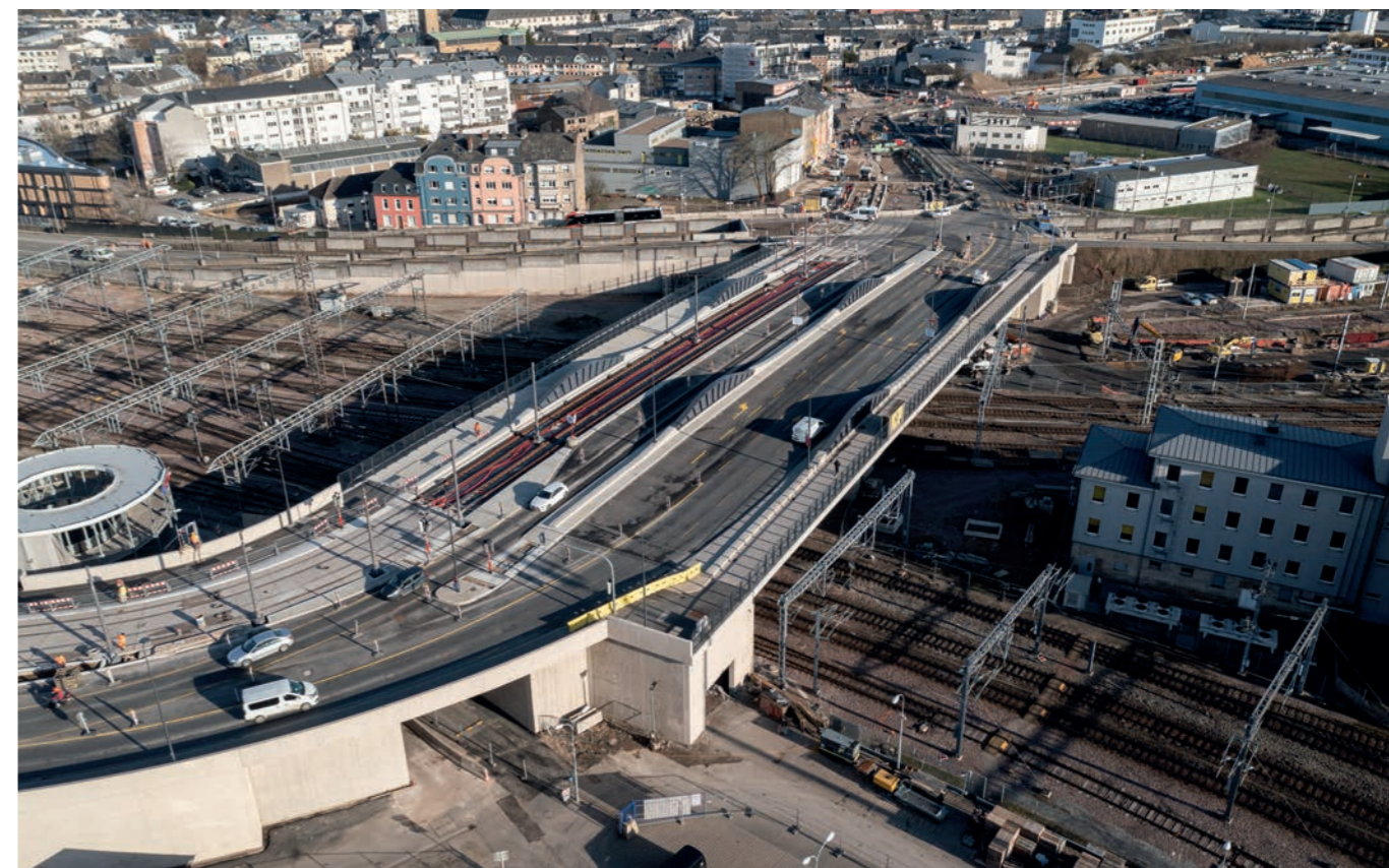
Finitions de la phase 2 du pont en cours © itchiban
