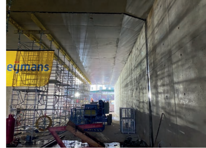
Joint de raccord entre les deux morceaux du cadre
