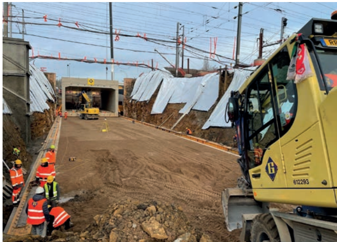
Vue du premier morceau de cadre à l'endroit où il doit être placé
