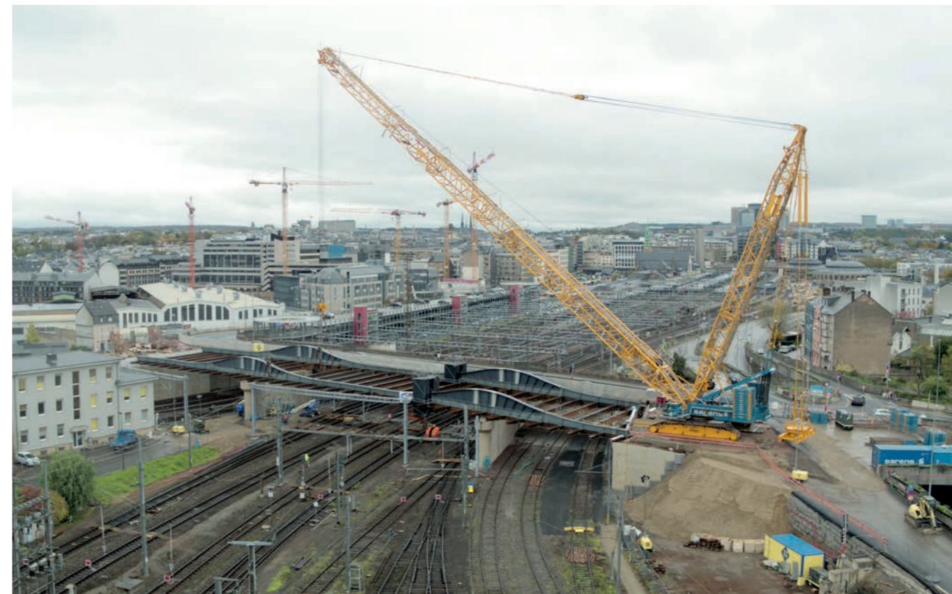
Montage phase 1 de la charpente du pont © Luxsense
