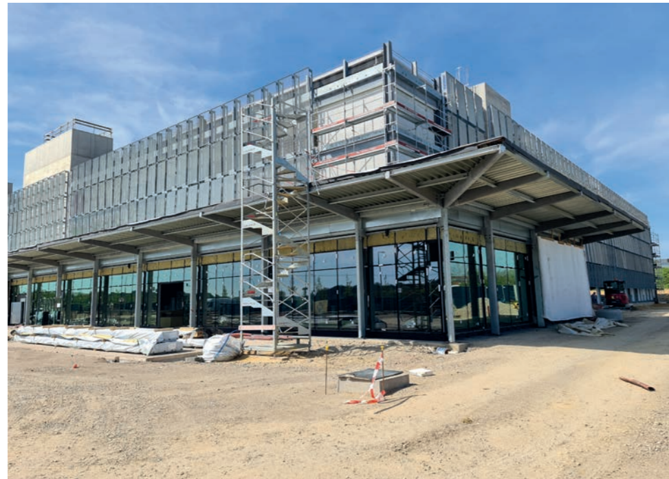
Auvent du bâtiment P&R en construction © Schroeder & Associés
