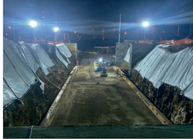
Terrassement dans l'emprise des voies déposées
