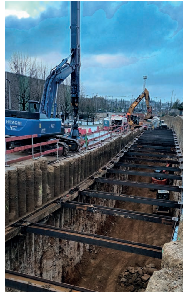
Etonçonnage du blindage des fouilles © Ponts & Chaussées
