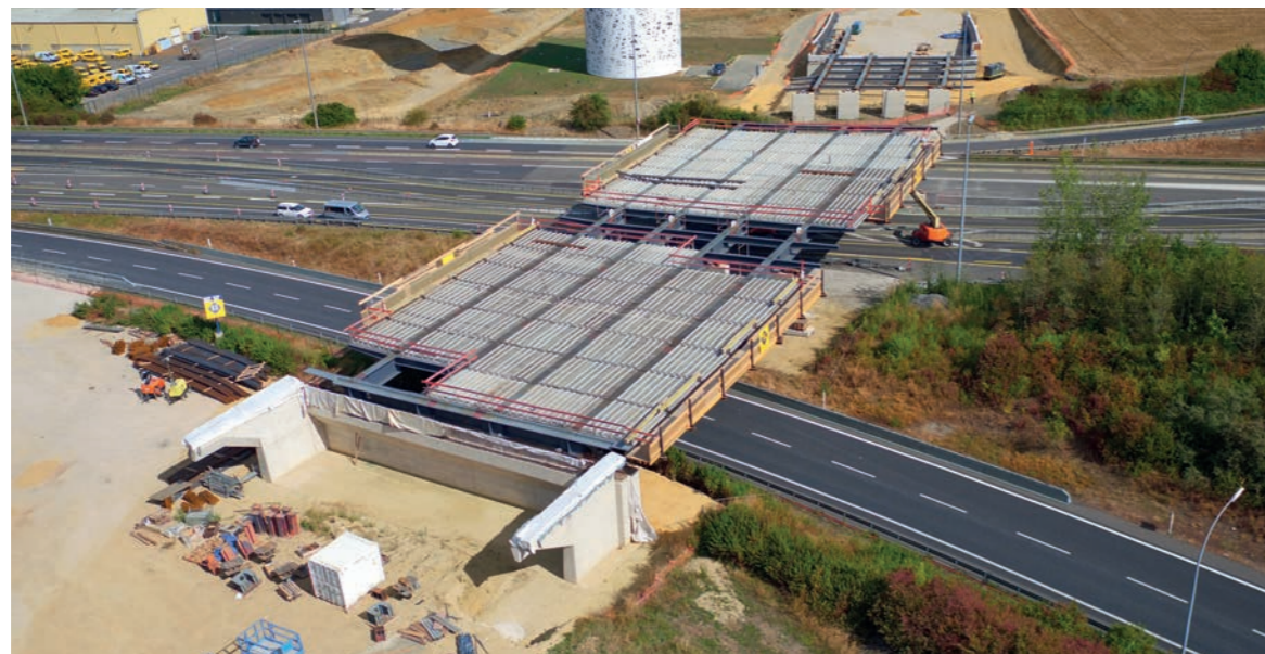
Tablier du pont en construction © Félix Giorgetti – Simon Schmitt GlobalView
