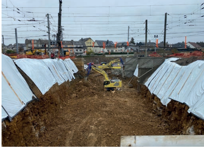
Terrassement dans l'emprise des voies déposées
