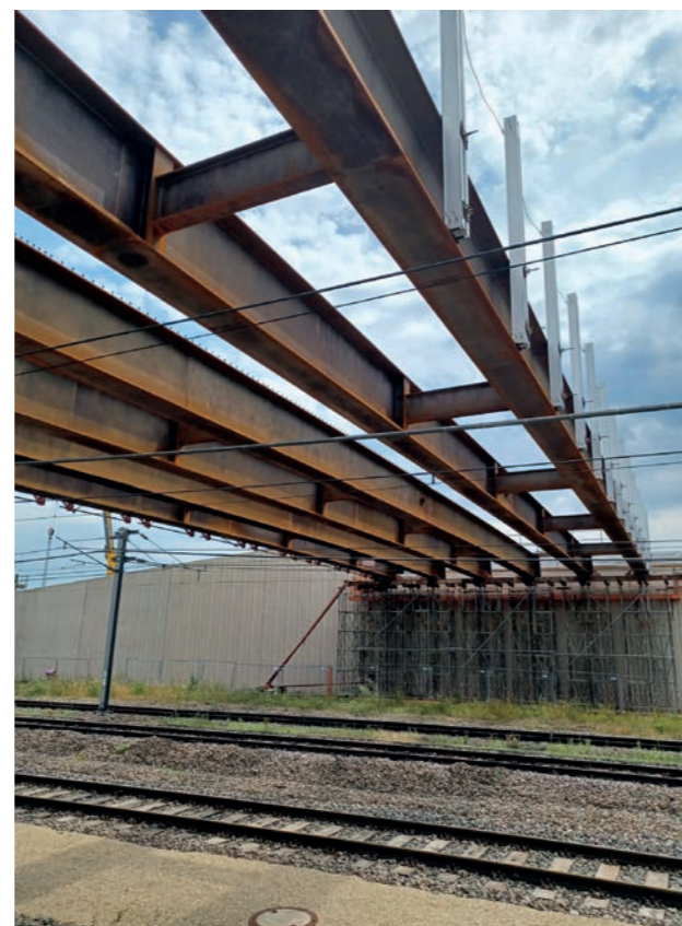
Charpente métallique en place © Schroeder & Associés
