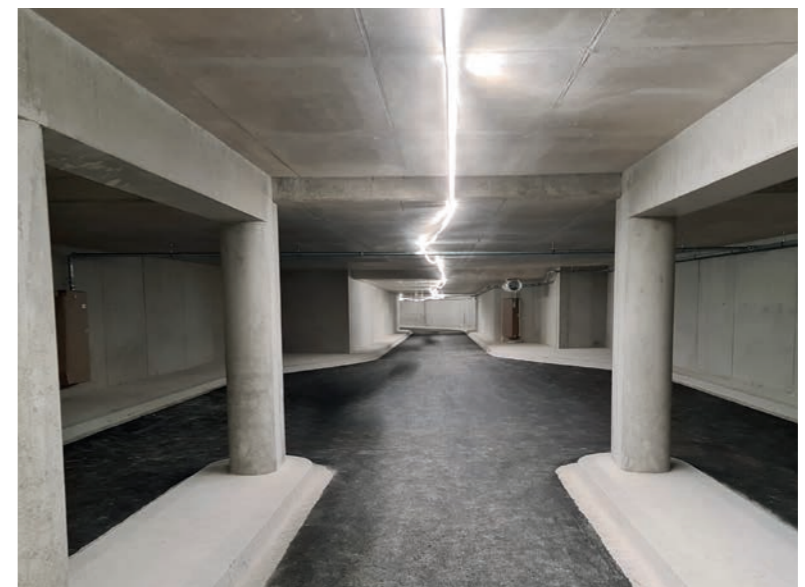
Accès sous-terrain au bâtiment P&R © Schroeder & Associés
