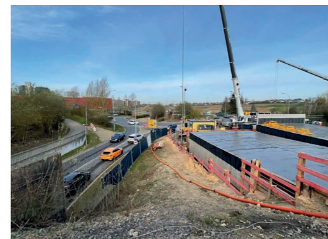
Cadres préfabriqués dans l'aire de préfabrication
