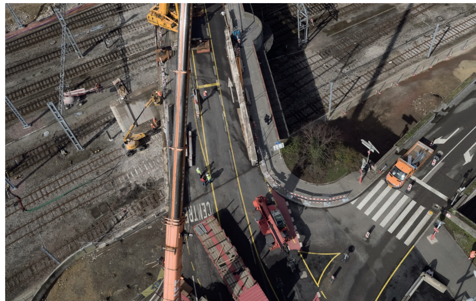
Ancien Pont Büchler en déconstruction © Ponts & Chaussées
