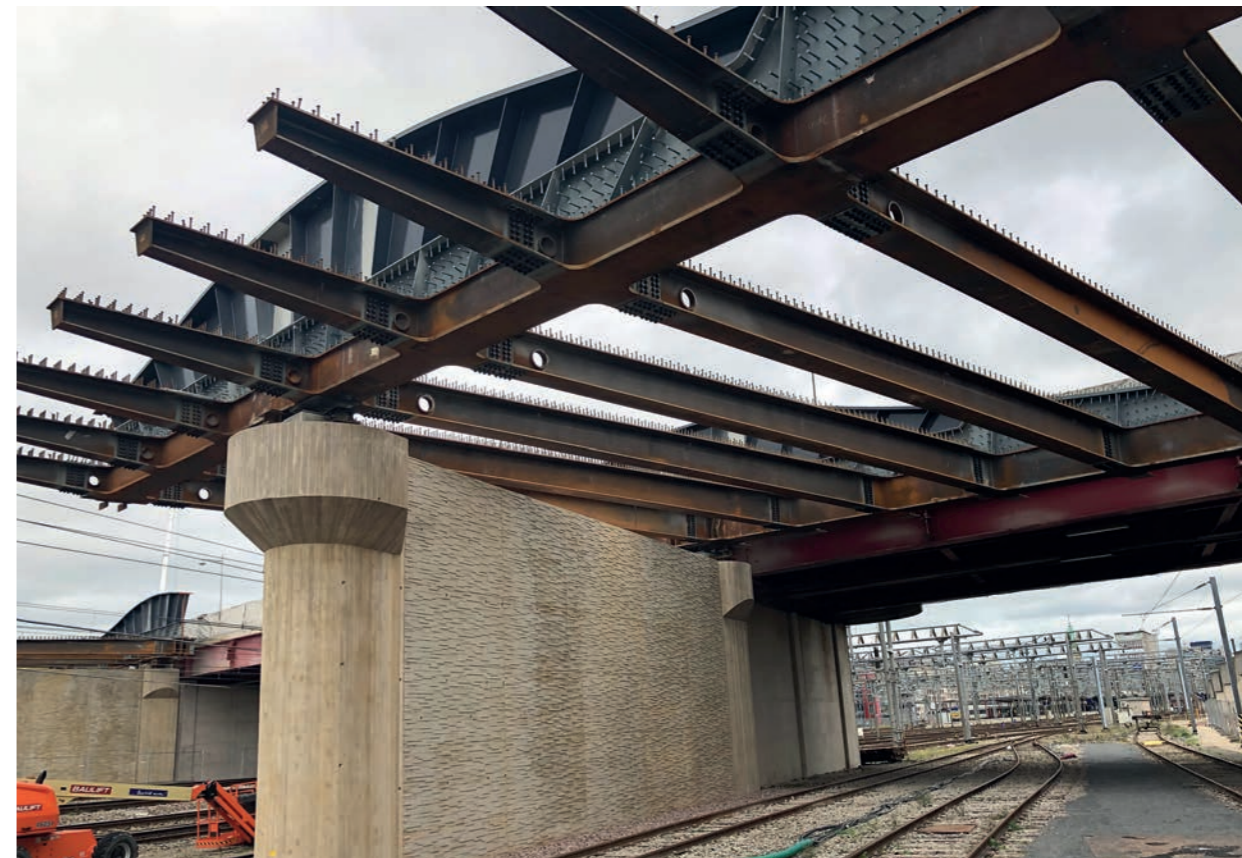
Assemblage de la charpente du Pont Büchler parallèlement à l'ancien pont © Schroeder & Associés
