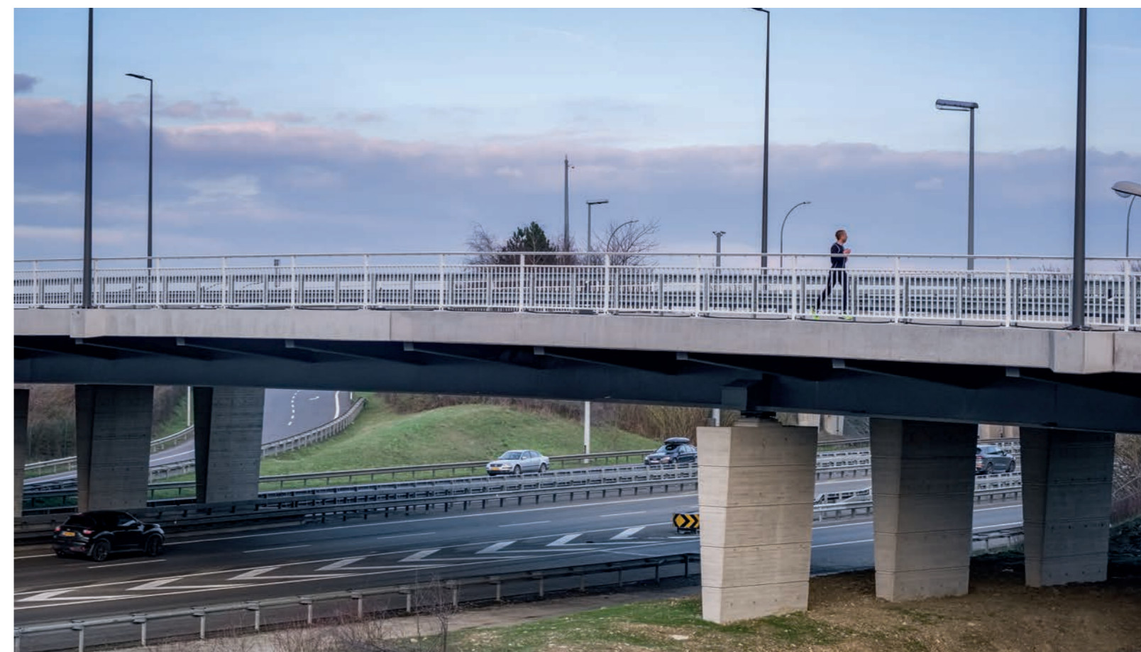
Vue OA900 Travée centrale A6 / Echangeur A3 © Christof Weber
