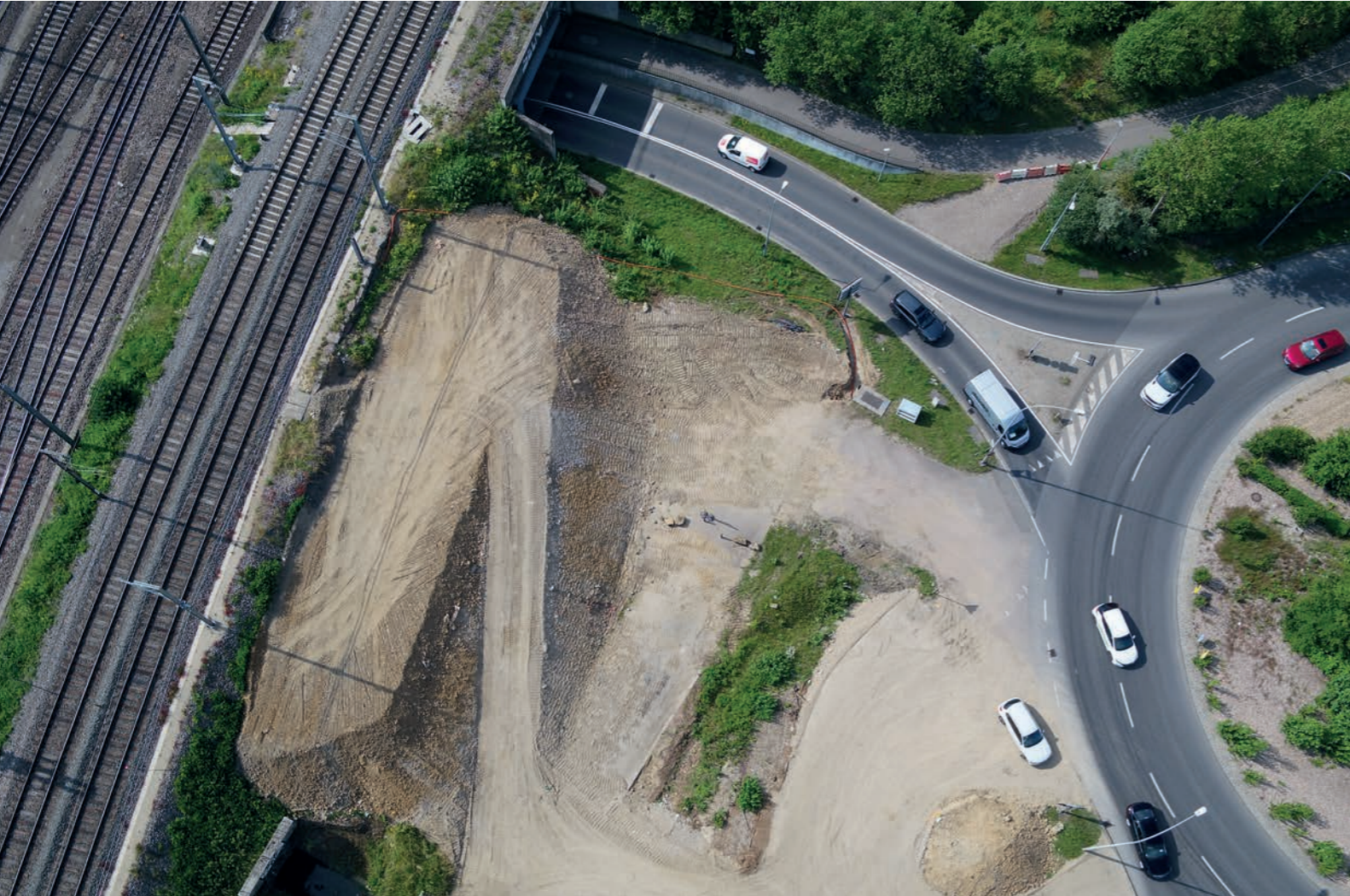
Vue aérienne sur le début du chantier Rangwee II © Frame Art
