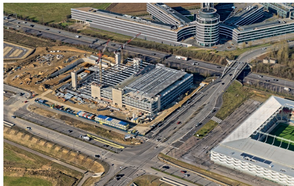
Vue aérienne Pôle d'échange en chantier © Félix Giorgetti – Simon Schmitt GlobalView
