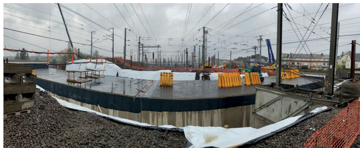
Rangwee II en chantier © Schroeder & Associés
