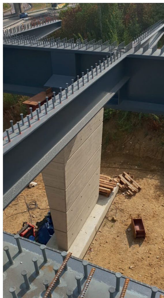
Vue sur pile intermédiaire avec charpente métallique montée © Schroeder & Associés
