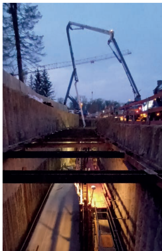
Ouvrage hydraulique (OH) Drosbach en construction © Ponts & Chaussées
