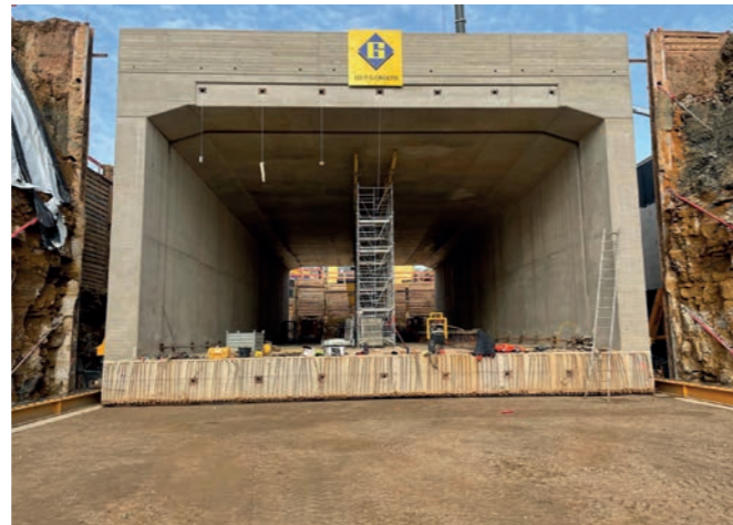
Vue du premier morceau de cadre à l'endroit où il doit être placé
