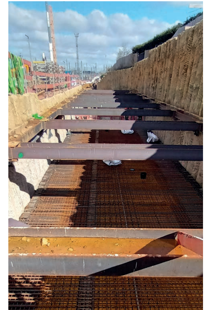
Etonçonnage du blindage des fouilles © Ponts & Chaussées
